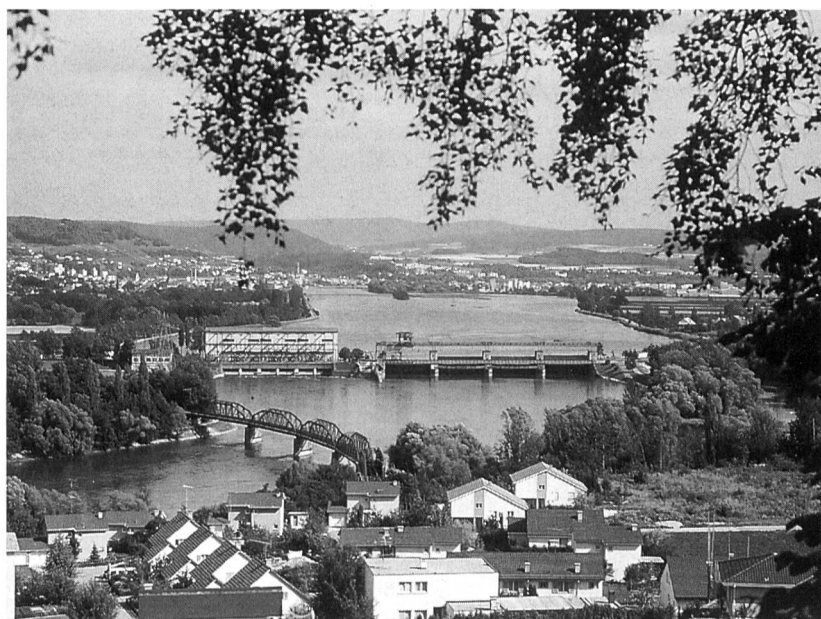
Bild 1. Das Kraftwerk Kling nau mit der Wehranlage vom Unterwasser gesehen.
