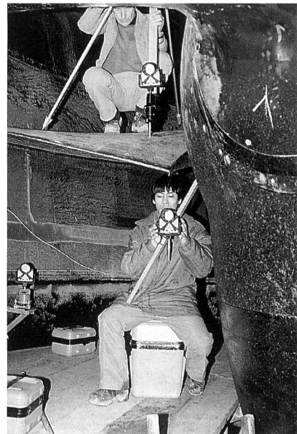
Bild 2. Vermessung der Laufschaufelkontur.
