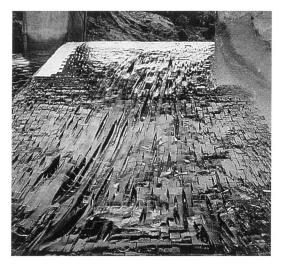
Bild 2. 500 000 m³ Geschiebe pro Jahr hinterlassen ihre Spuren: Die früheren Beton- und Holzauskleidungen mussten jährlich aufwendig saniert werden.
