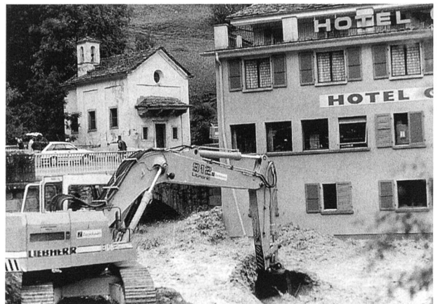
Bild 3. 1994er Hochwasser am Chrummbach/Simplon. Zwei Bagger halten den Brückendurchlass bei Gabi frei (Bild: J. Escher).
