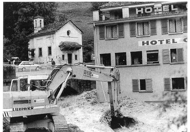
Bild 3. 1994er Hochwasser am Chrumbach/Simplon. Zwei Bagger halten den Brückendurchlass bei Gabi frei (Bild: J. Escher).
