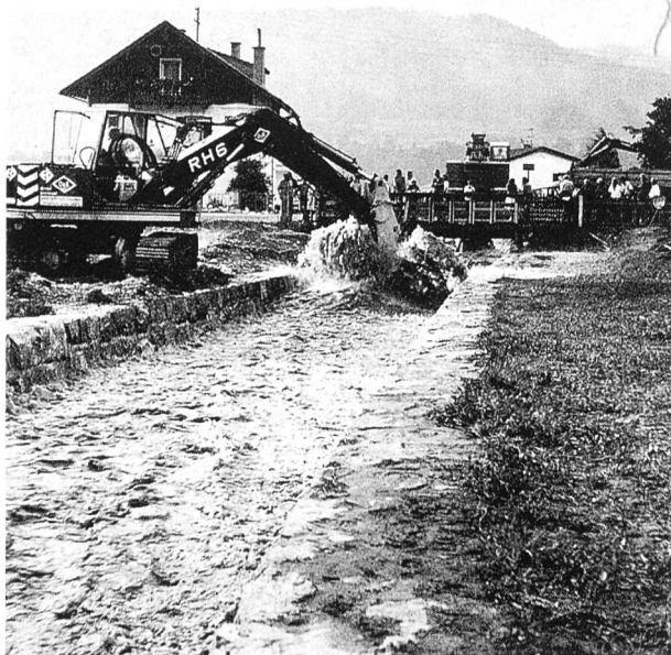
Bild 1. Volderbach bei Hochwasser mit stehenden Wellen, die das Freibord verringern (Bild: H. Lang).
