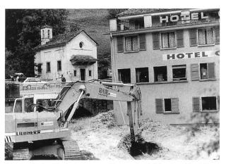
Bild 3. 1994er Hochwasser am Chrummbach/Simplon. Zwei Bagger halten den Brückendurchlass bei Gabi frei (Bild: J. Escher).
