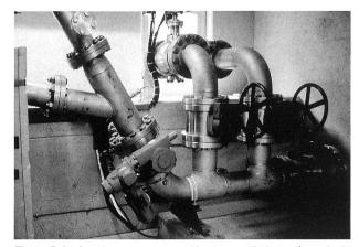
Figure 3. Le jeu de vannes automatiques: on distingue à partir de la droite, en bas, l'arrivée de la conduite forcée de Médières, précédée immédiatement par la vanne d'entrée manuelle; puis deux bypass, le premier étant manuel, le second automatique. Juste avant que la conduite de 300 mm ne se sépare en deux vers les injecteurs, on distingue la vanne d'entrée automatique.
