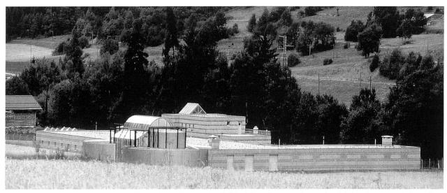
Figure 1. Vue d'ensemble de la station d'épuration de Bagnes-Le Châble, à laquelle on a adjoint le local de la micro-centrale hydroélectrique. Les bâtiments sont complètement couverts pour prévenir l'usure prématurée des installations par les intempéries, la neige et le froid qui règne en hiver, mais aussi pour épargner au voisinage les désagréments du bruit et des odeurs.
