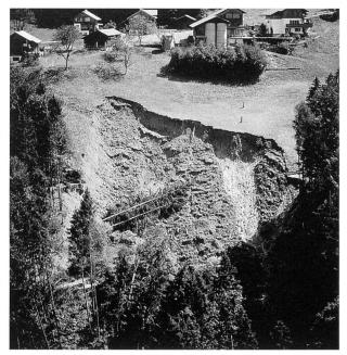
Bild 5. Rutschung im Ortsteil Burkat, Triesenberg FL, 31. Juli 1995. Infolge Tiefenerosion verlor der Hang seine seitliche Stabilität. Eine Fläche von 1,5 Hektaren rutschte samt Waldbestockung und Strasse etwa vier Stunden nach dem Rüfengang ab.
