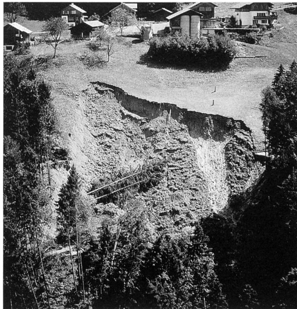
Bild 5. Rutschung im Ortsteil Burkat, Triesenberg FL, 31. Juli 1995. Infolge Tiefenerosion verlor der Hang seine seitliche Stabilität. Eine Fläche von 1,5 Hektaren rutschte samt Waldbestockung und Strasse etwa vier Stunden nach dem Rüfengang ab.
