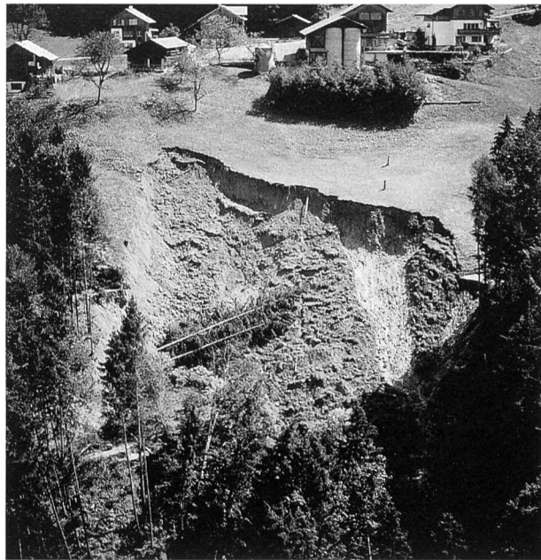
Bild 5. Rutschung im Ortsteil Burkat, Triesenberg FL, 31. Juli 1995. Infolge Tiefenerosion verlor der Hang seine seitliche Stabilität. Eine Fläche von 1,5 Hektaren rutschte samt Waldbestockung und Strasse etwa vier Stunden nach dem Rūfengang ab.
