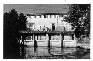
Die erste Phase der Werkerneuerung im Kraftwerk Wildegg-Brugg bei Villnachern konnte Mitte Juli 1995 mit der Wiederinbetriebnahme der Maschinengruppe 1 abgeschlossen werden. Wirkungsgradverbesserungen an Turbine und Generator erlauben künftig eine bessere Ausnützung der turbinierten Wassermenge. Die Betreiber erhoffen sich davon eine Kraftwerk-Mehrproduktion von etwa 2,5 %.
