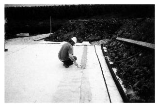
Bild 2. Kantenabspachtelung der Dichtungsmatte Bentofix D 4000.
