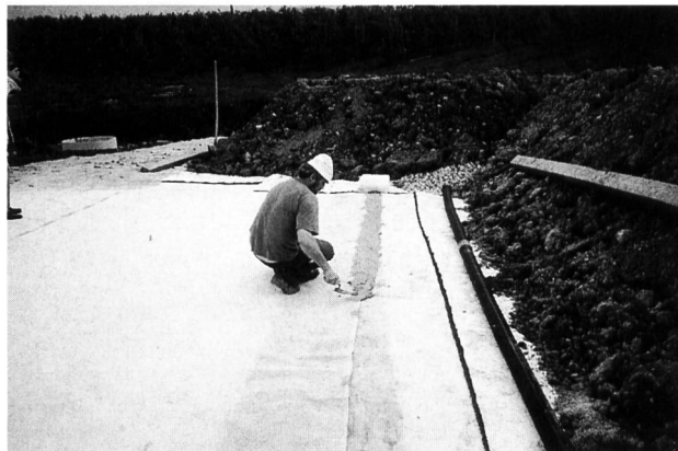
Bild 2. Kantenabspachtelung der Dichtungsmatte Bentofix D 4000.
