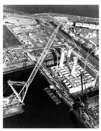
Bild 2. Betonplattform von Bild 1 in einem Dock in Rosenburg in den Niederlanden betoniert; Einbau von vorgefertigten Stahlbetonplatten als Deckel für Speicher- und Ballastzellen mit Hilfe eines grossen Schwimmkranes Taklift 7.
