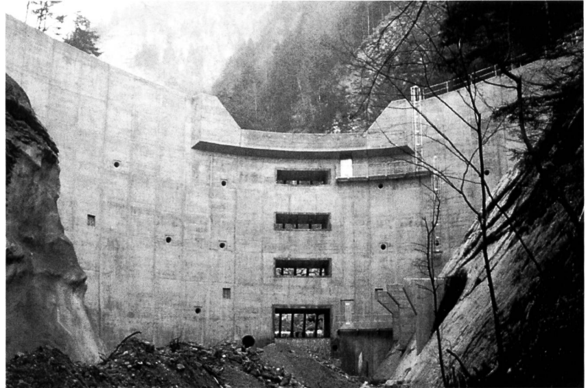
Bild 3. Geschieberückhaltesperre Palanggenbach. Aushub rechtes Widerlager mit Stabilisierungsmassnahmen über der künftigen Kronenkote.
