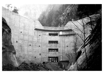
Bild 3. Geschieberückhaltesperre Palanggenbach. Aushub rechtes Widerlager mit Stabilisierungsmassnahmen über der künftigen Kronenkote.
