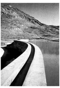
Bild 3. Die Bernina-Nordmauer bildet den Seeabschluss gegen das Engadin. Die Gewichtsmauer besteht aus drei aneinandergereihten Bogen.
