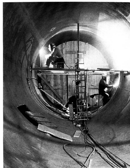
Bild 6. Schweissarbeiten an der Panzerung beim Druckschachtfuss.
