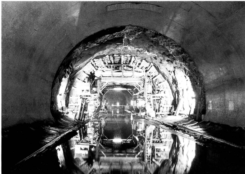
Bild 2. Vereinigter Druckstollen zwischen den Drosselklappenkammern 1 und 2.
