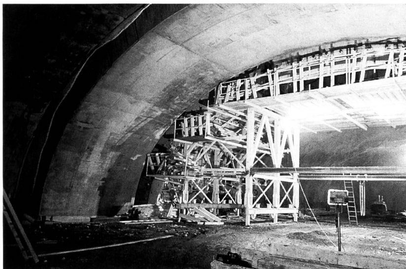
Bild 5. Regulierkaverne, Beton und Schalung des Gewölbes.
