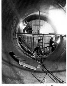
Bild 6. Schweissarbeiten an der Panzerung beim Druckschachtfuss.
