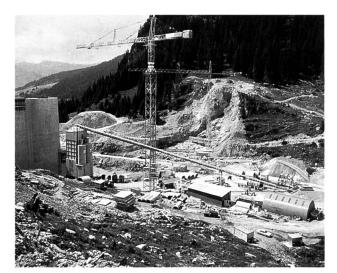
Bild 10. Aushub und erste Betonierarbeiten Staumauer Panix.
