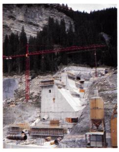
Bild 2. Bau des linken Widerlagers der Staumauer
