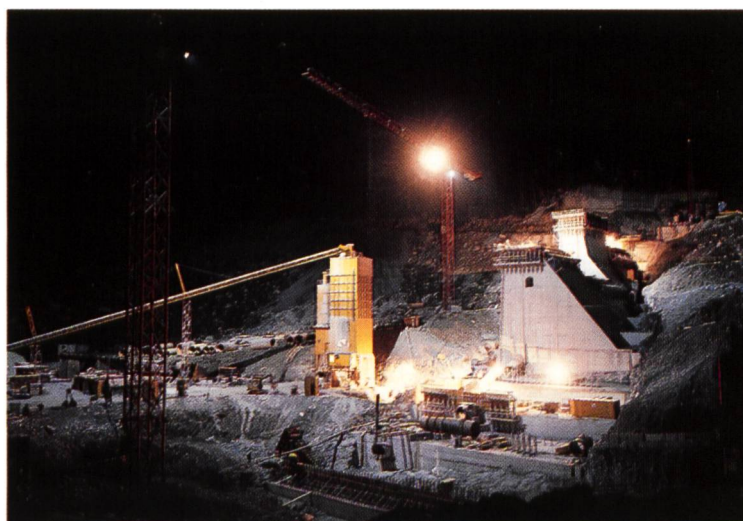
Bild 9. Aufbereitungsanlage mit Betonturm und Krananlage.
