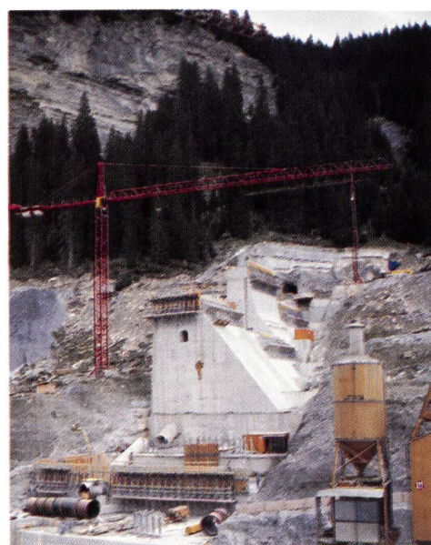
Bild 2. Bau des linken Widerlagers der Staumauer Panix.
