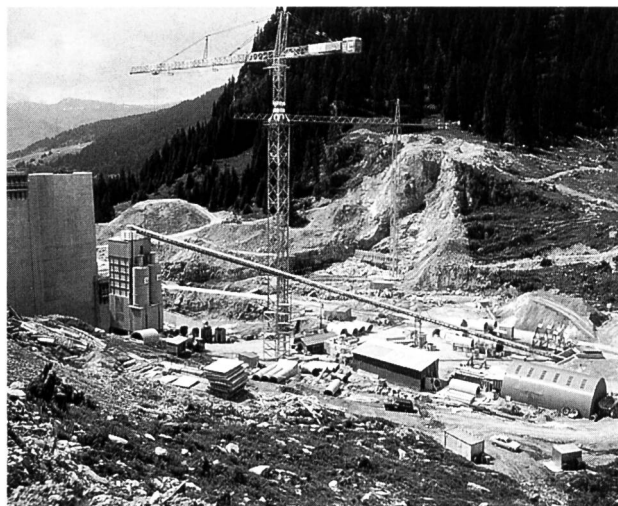
Bild 10. Aushub und erste Betonierarbeiten Staumauer Panix.
