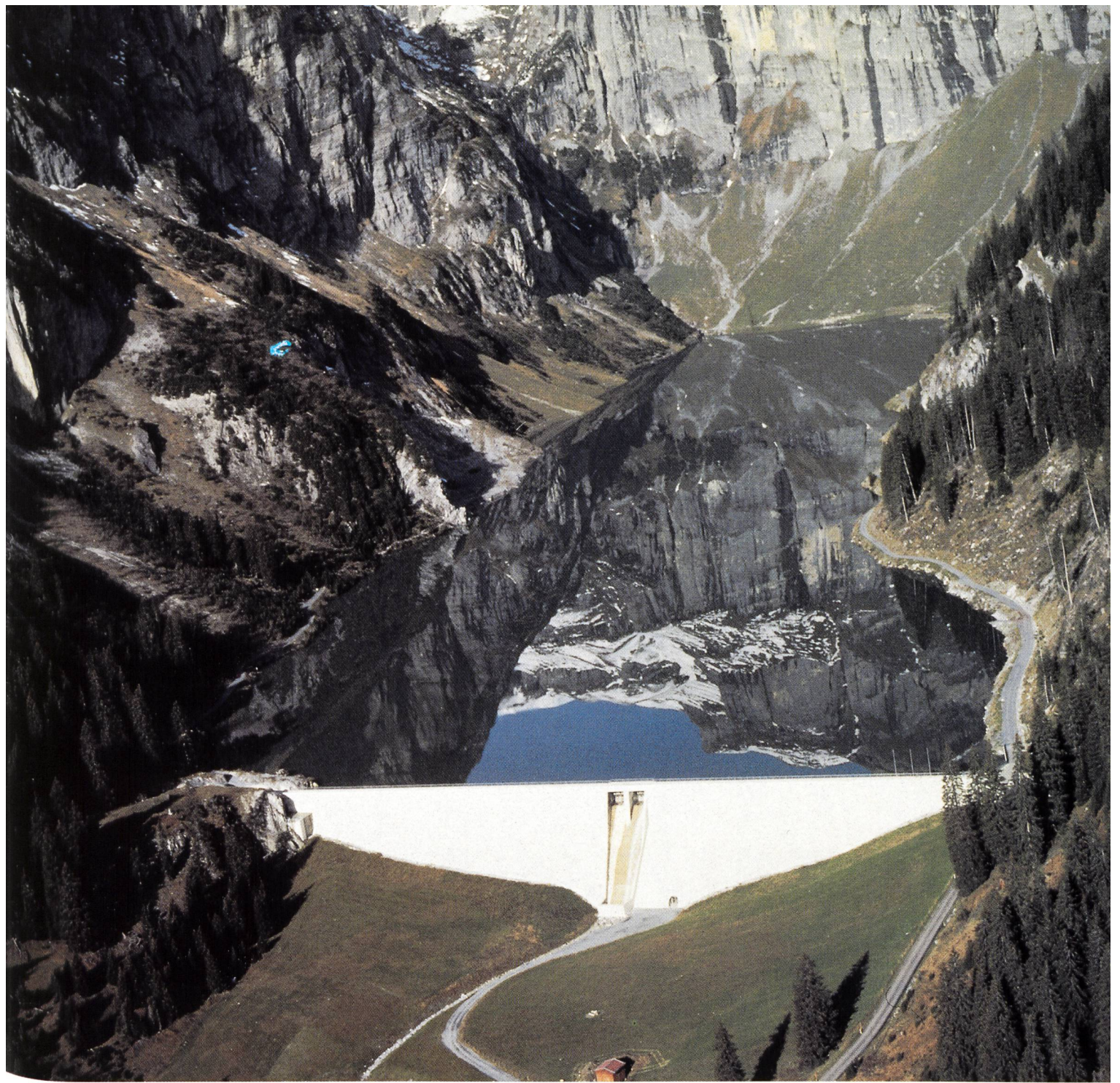
Die Staumauer Panix der Kraftwerke Ilanz AG staut bis 7,3 Mio m 3 Nutzinhalt. Sie ist 53 m hoch; ihre Krone ist 240 m lang, und die Betonkubatur beträgt 160 000 m 3 (siehe auch die Beiträge S. 233–253).
