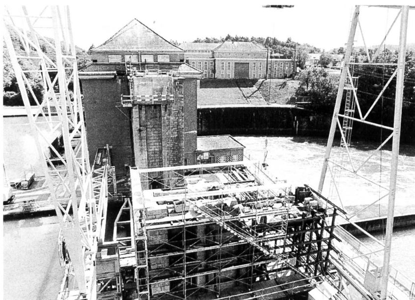
Bild 1. Die beim Kraftwerk Eglisau unabhängig von der Konzessionserneuerung angeordneten Sanierungsarbeiten an der Wehranlage werden voraussichtlich bis 1999 dauern. Der Abbau und die Rekonstruktion der Wehrpfeiler (im Bild Pfeiler 1) erfordern jeweils die vorgängige Demontage der Windwerkbrücke in den beiden betroffenen Wehrfeldern. (Fotos: Bruno Meier, KW Eglisau)
