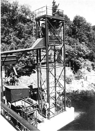
Bild 4. Fischlift beim Elektrizitätswerk Castet. Der Liftkorb befindet sich bei der oberen Schachtöffnung, von der aus eine Rohrverbindung zum Blechkanal Richtung Oberwasser führt. Foto: Ruhlé
