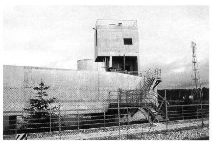
Bild 4. Fischlift beim Elektrizitätswerk Castet. Der Liftkorb befindet sich bei der oberen Schachtöffnung, von der aus eine Rohrverbindung zum Blechkanal Richtung Oberwasser führt. Foto: *Ruhlé*
