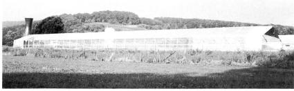
Bild 2. Trocknungsanlage in Kandern-Hammerstein – 6000 EG, 500 t/Jahr; Grösse 8 m breit, 56 m lang, Turmhöhe 7,70 m.
