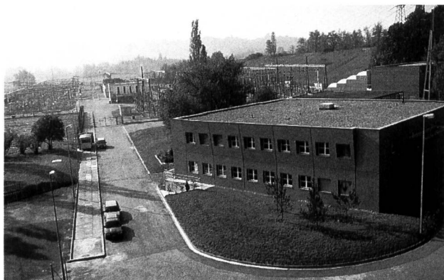
Figure 3. Le nouveau bâtiment du Centre de gestion hydraulique.
