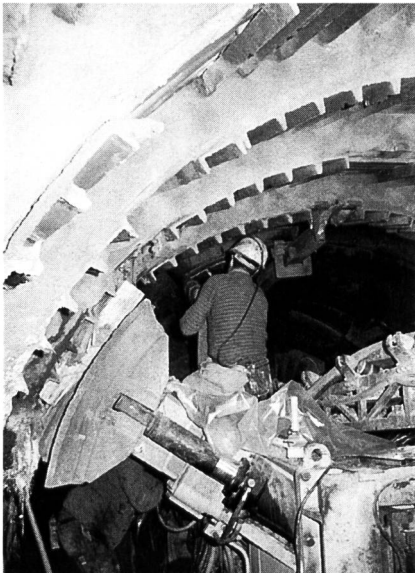
Bild 2. Profilanpassung bei der Durchfahrung der Triasformation durch Marciavertverfahren.
