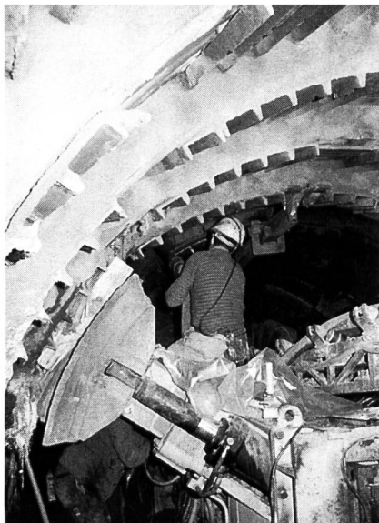
Bild 2. Profilanpassung bei der Durchfahrung der Triasformation durch Marciantverfahren.
