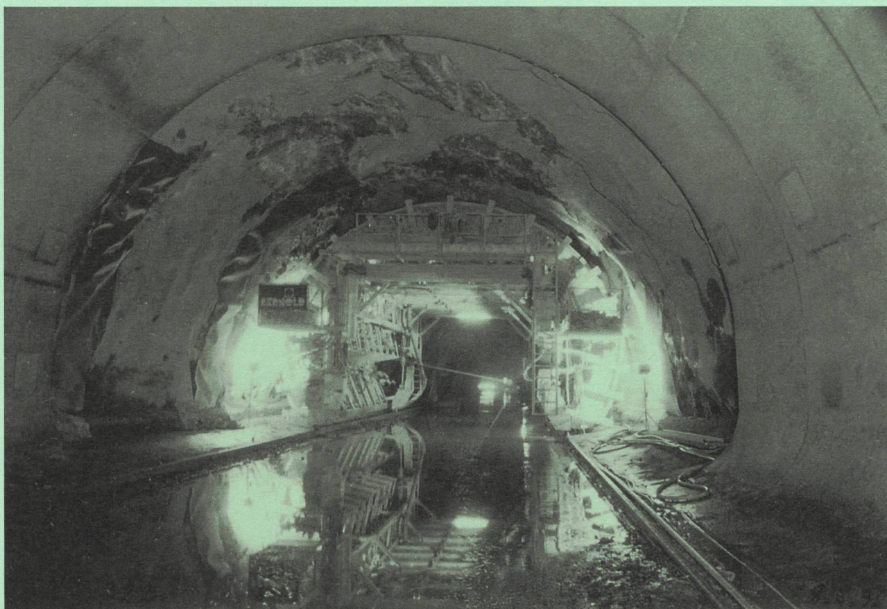
Erneuerung Kraftwerk Amsteg – Schalungswagen für den Verkleidungsbeton im Unterwasserstollen.
