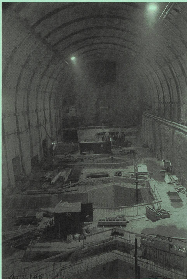
Erneuerung Kraftwerk Amsteg der SBB – Kavernenzentrale mit Turbinengruben und Ausläufen in den Unterwasserkanal. (Foto: A. Meinardi, IUB)
