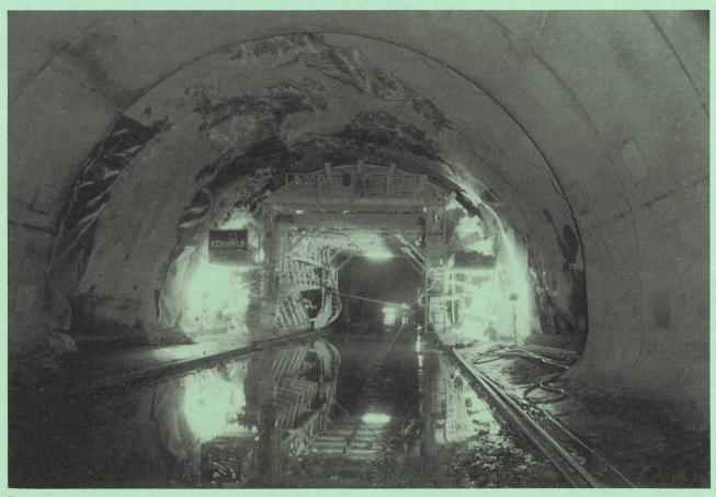
Erneuerung Kraftwerk Amsteg - Schalungswagen für den Verkleidungsbeton im Unterwasserstollen.
