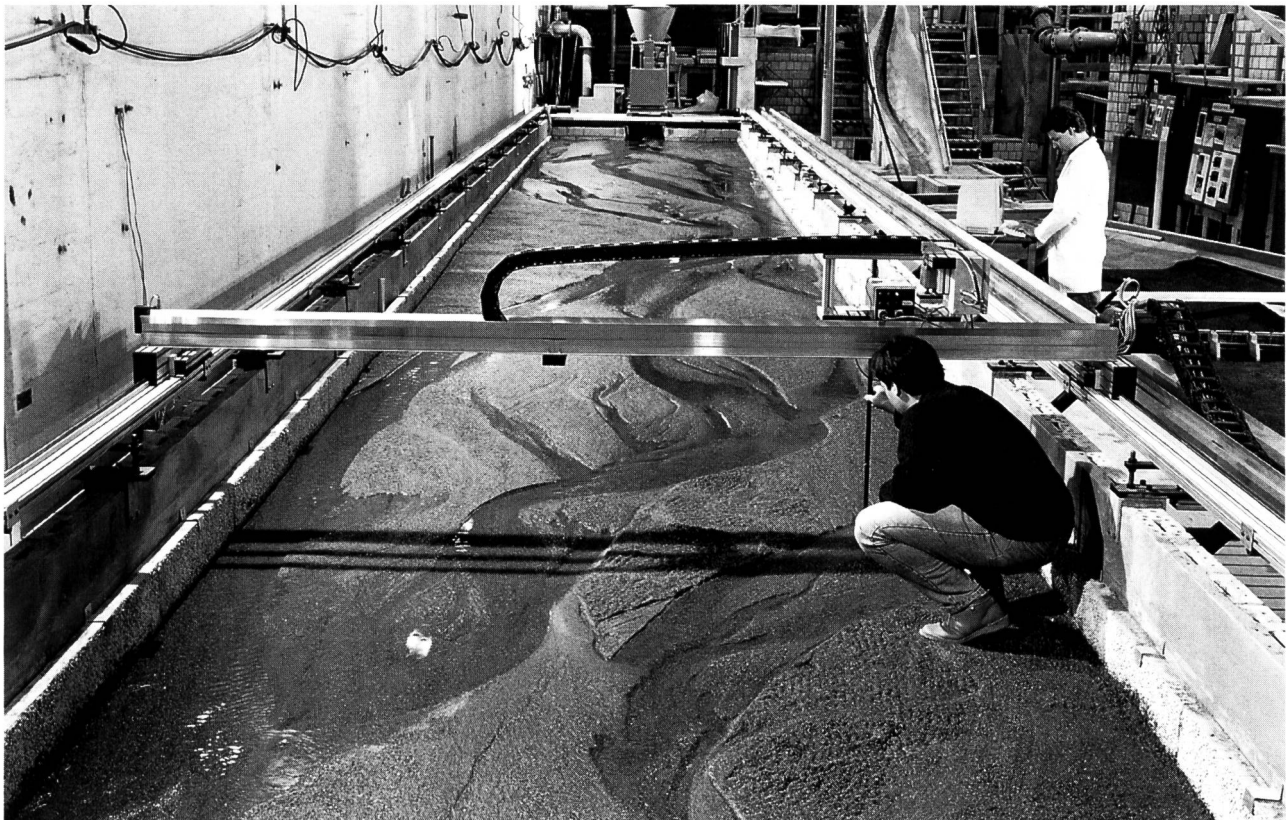
Bild 5. Versuchsstand zur Ermittlung der Geschiebeführung bei verschiedenen Flussbreiten; Blick gegen die Fliessrichtung (Foto VAW 27647).
