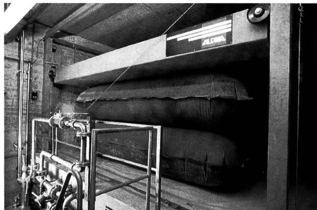
Bild 2. Der Kissengasspeicher puffert die erzeugte Biogasmenge (1994 rund 548 m³ pro Tag).
