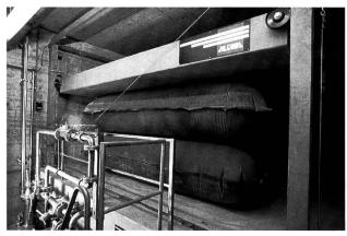
Bild 2. Der Kissengasspeicher puffert die erzeugte Biogasmenge (1994 rund 548  $\rm m^3$  pro Tag).
