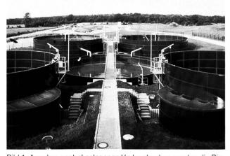
Bild 1. Aus dem zentral gelegenen Vorlagebecken werden die Bioreaktoren im Hintergrund stossweise mit Abwasser beschickt. Die Schlammstapelbecken (vorn) nehmen Überschussschlamm auf. Alle Behälter wurden aus in der Landwirtschaft gebräuchlichen emaillierten Stahlprofilen gefertigt – einer der Gründe für die relativ geringen Baukosten der Anlage. (Foto: Ed. Kliffen)
