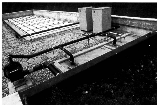
Bild 3. Die Abluft aus dem Reaktor wird vor dem Austritt in die Umgebung im Biofilter (im Vordergrund) gereinigt.
