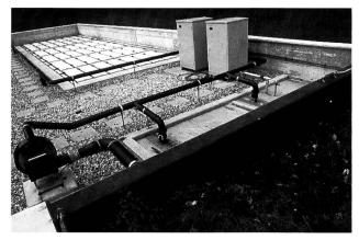
Bild 3. Die Abbluft aus dem Reaktor wird vor dem Austritt in die Umgebung im Biofilter (im Vordergrund) gereinigt.
