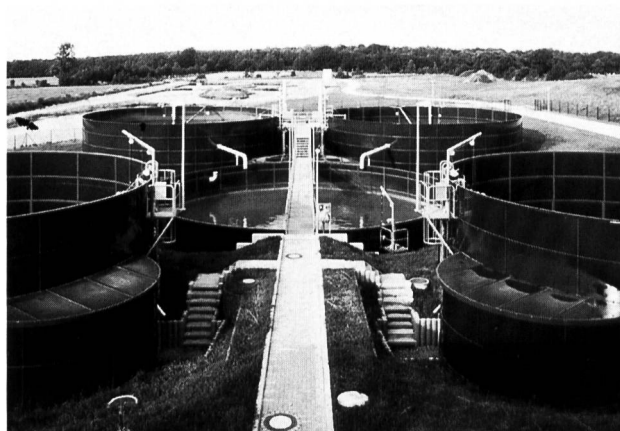
Bild 1. Aus dem zentral gelegenen Vorlagebecken werden die Bioreaktoren im Hintergrund stossweise mit Abwasser beschickt. Die Schlammstapelbecken (vorn) nehmen Überschussschlamm auf. Alle Behälter wurden aus in der Landwirtschaft gebräuchlichen emaillierten Stahlprofilen gefertigt – einer der Gründe für die relativ geringen Baukosten der Anlage. (Foto: Ed. Kliffen)
