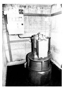
Bild 2. 4 l/s und 100 m Fallhöhe: Damit liefert die kleine Anlage (Drehstromgenerator mit direkt gekoppelter Peltonturbine) auf der Voralp Hirzboden rund um die Uhr 2,5 kW, bei 7 l sogar 4 kW.
