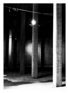
Bild 2. Reservoirkammern Lyren. Der Reservoirbeton in Lyren ist dank Betonzusätzen wasserdicht und trinkwassertauglich.
