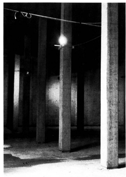
Bild 2. Reservoirkammern Lyren. Der Reservoirbeton in Lyren ist dank Betonzusätzen wasserdicht und trinkwassertauglich.
