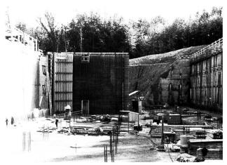
Bild 3. Stellen der Wandelementschalung. Gefordert ist ein Sichtbeton mit möglichst glatter Oberfläche. Eingesetzt wurde nach eingehenden Vorversuchen eine Elementschalung aus Holz.
