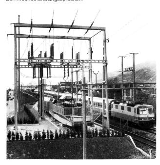
Bild 1. Ein fahrbares Unterwerk in Stellung in Saint-Léonard, Wallis. Die Aufnahme entstand im November 1980. Nach einigen Jahren ist von den beiden Wagen nicht mehr viel zu sehen, denn um den Zaun wurden Thujen angepflanzt. Sichtbar bleibt die Einführung der mit 132 kV betriebenen Übertragungsleitung.
