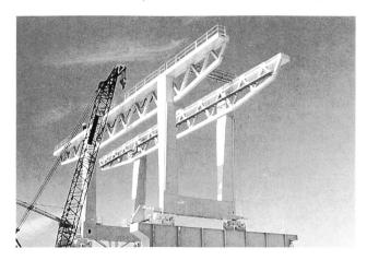
Die Spurweite des Kranes beträgt 22 m, die Hubhöhe des Haupthubwerkes 55 m. Alle Antriebe wurden stufenlos regelbar ausgeführt, um genaue Steuerbarkeit für die heiklen Montageeinsätze und höchste Verfügbarkeit auch nach langen Stillstandszeiten zu gewährleisten.
