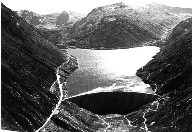
Bild 1. Ansicht der Talsperre Santa Maria.
