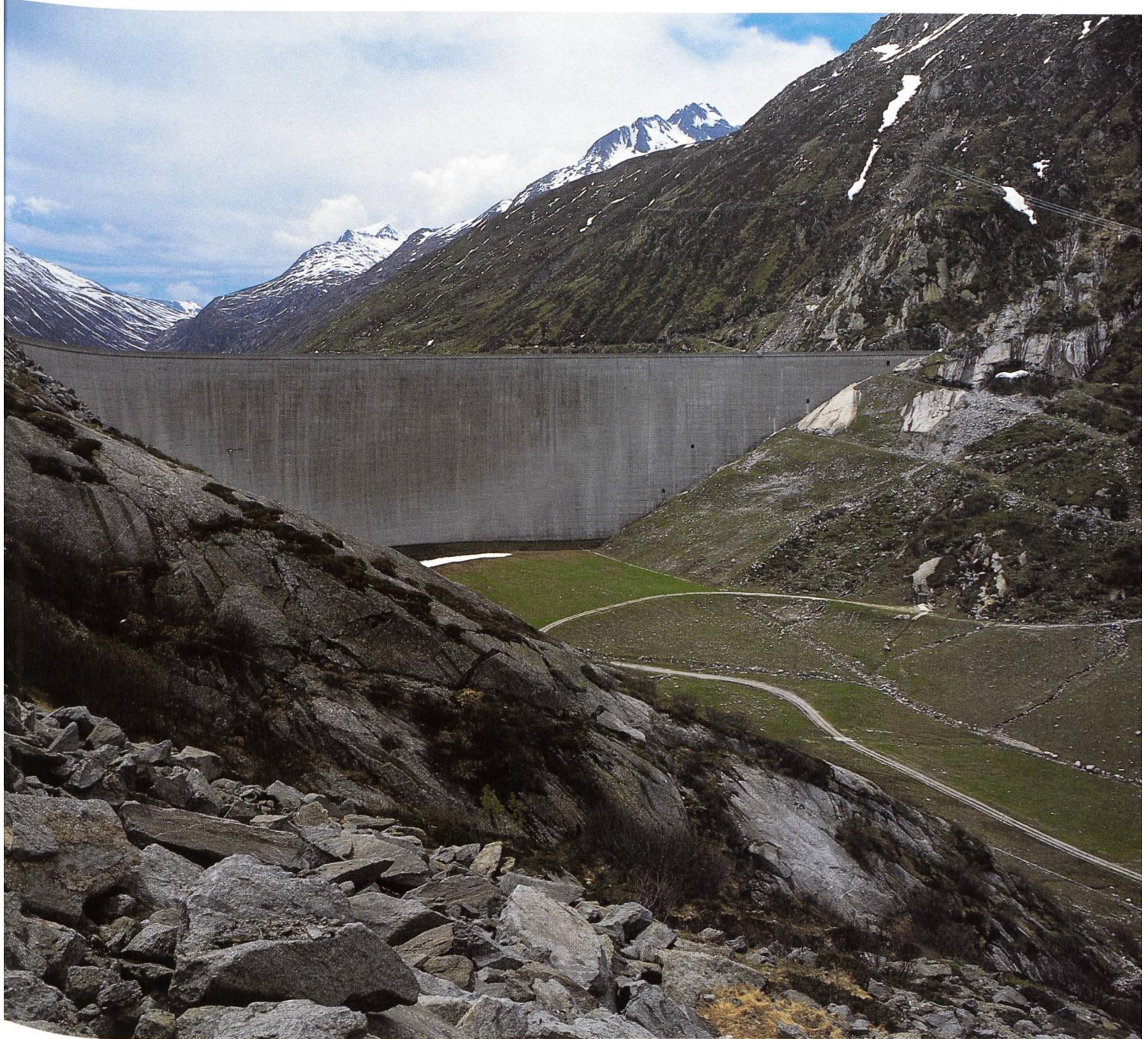
Die Staumauer von Santa Maria der Kraftwerke Vorderrhein AG wurde in den Jahren 1964 bis 1968 gebaut. Zur Kontrolle der gemessenen Verformungen der Mauer wurde ihr Fundationsverhalten genauer untersucht. Der Verformungsmechanismus konnte dadurch lückenlos abgeklärt werden. Die Ergebnisse sind auf Seite 67 – 72 dargestellt.
