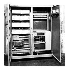
Bild 8, links. Automatisierungseinheit in den Aussenstationen.
