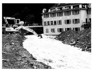
Bild 7. Hochwasser des Chrummbaches bei Gabi VS am 24. September 1994. Dank Sofortmassnahmen wie Ausbaggerung des Bachbettes und Erstellen von provisorischen Schutzdämmen konnten schwerere Schäden vermieden werden.
