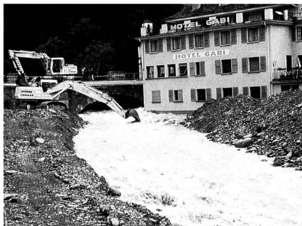
Bild 7. Hochwasser des Chrummbaches bei Gabi VS am 24. September 1994. Dank Sofortmassnahmen wie Ausbaggerung des Bachbettes und Erstellen von provisorischen Schutzdämmen konnten schwerere Schäden vermieden werden. Foto: J. Escher, Gemeindekanzlist, Simplon-Dorf
