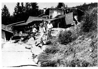
Bild 3. Auswirkungen der Rutschung «Chlöwena», Gemeinde Plasselb im freiburgischen Sensebezirk. Das massiv gebaute Hotel Falli-Hölli wurde von den Rutschungsbewegungen destabilisiert und zerstört und die Zufahrtsstrasse bis zu drei Metern angehoben. Die Aufnahme zeigt die Situation am 26. Juli 1994.
