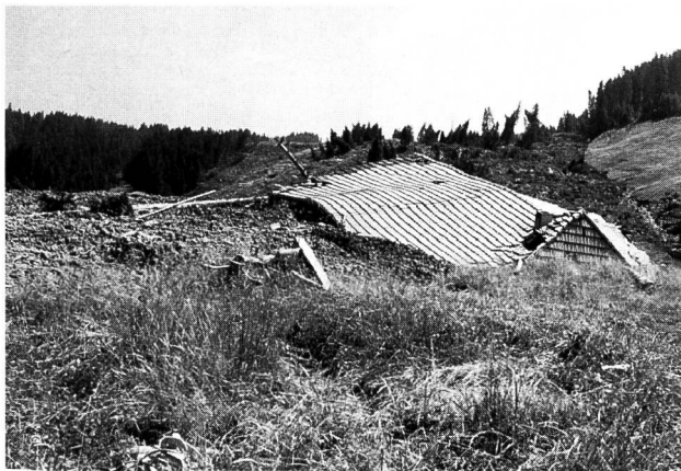
Bild 4. Rutschung «Chlówena», 26. Juli 1994. Auf dem Foto sehen wir ein zerstörtes Bauernhaus. Einzig das Dach «schwimmt» noch auf den sich bis zu vier Metern pro Tag talwärts bewegendem Erdmassen. Foto: W. Gerber, WSL
