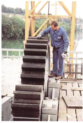
Bild 6-36. Revision der Wehrschützenantriebe im Zuge der Ausbauarbeiten.
