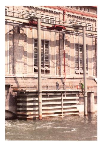
Bild 6-18. Die Tafeln für den unterwasserseitigen Saugrohrverschluss werden mit Hilfe eines Umsetzkrans gesetzt und gezogen.
