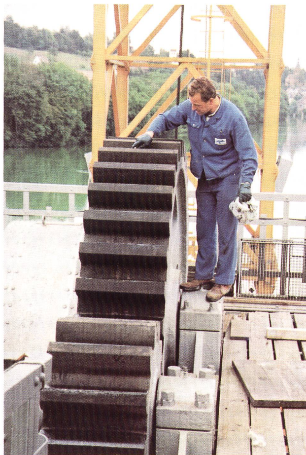
Bild 6-36. Revision der Weherschützenantriebe im Zuge der Ausbaurbeiten.
