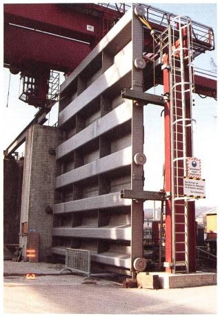
Bild 6-17. Anstelle von Einlaufschützen und Gleitdammbalken dienen jetzt Rolldammtafeln als oberwasserseitige Abschlüsse der Turbineneinläufe.
