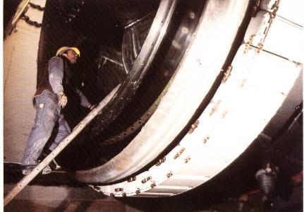
Bild 6-14. Letzte Montagearbeiten an Generator 1 und der Probebetrieb von «Andrea» kann beginnen.
