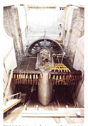
Bild 6-4. Aufbetonieren des Tragkreuzes im Turbineneinlauf. Es dient zur Verankerung der Turbine und zur gleichmässigen Strömungsumlenkung.
