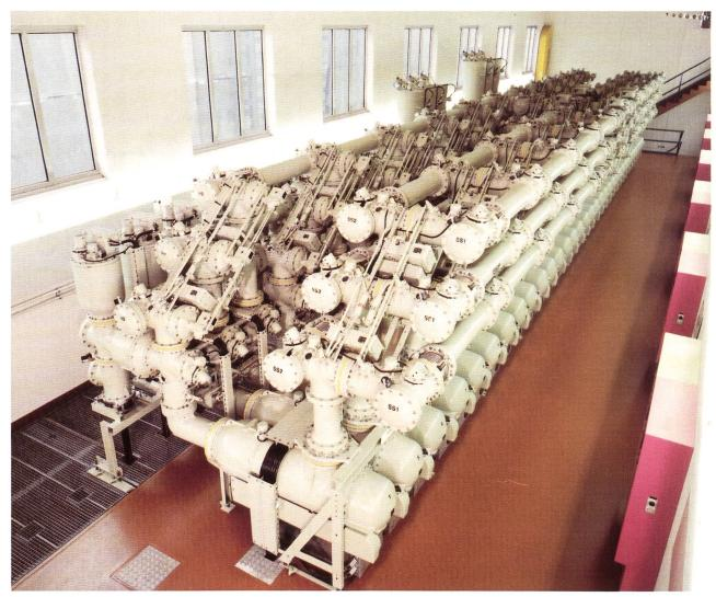
Bild 6-25. Verknüpfung der Energieableitung mit dem KWL-Netz in der SF<sub>6</sub>-Gas-isolierten 110-kV-Schaltanlage.
