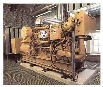
Bild 6-35. Für den Störungsfall gerüstet: Die neue Dieselnotstromgruppe ist für die Aufrechterhaltung der Versorgung aller betriebsnotwendigen Einrichtungen ausgelegt.
