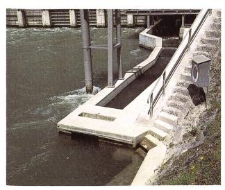
Bild 12-2. Der Fischpass am Schweizer Ufer wurde im Zuge der Ausbauarbeiten den geänderten Abströmungsverhältnissen beim Rheinkraftwerk angepasst und nach den neuesten Erkenntnissen umgestaltet.
