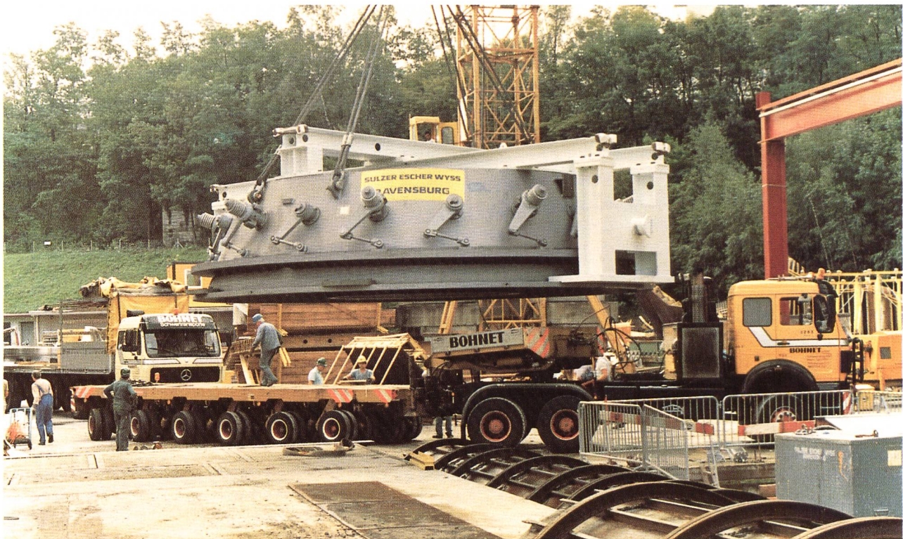
Bild 6-8. Ein Leitapparat wird angeliefert.
