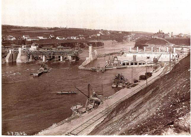
Bild 3-1. Am 27. März 1912: Nach etwa der halben Bauzeit nimmt das Rheinkraftwerk Laufenburg, das damals grösste Laufwasserkraftwerk Europas, Gestalt an.
