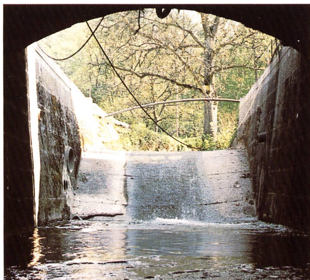
Bilder 12-4. Ersatz des vor 30 Jahren errichteten Wassersturzes (links) an der Sulzerbach-Mündung durch einen Fischaufstieg (rechts).
