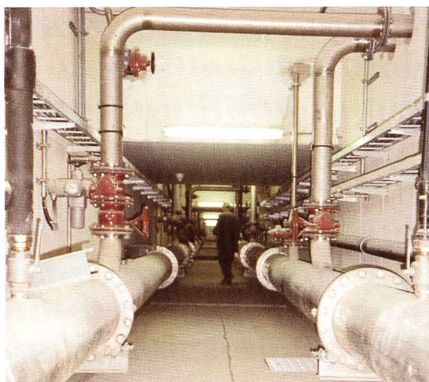
Bild 6-32. Der Rohrkanal: Die Bedeutung der Wasserkühlung für den reibungslosen Werksbetrieb in Verbindung mit der beachtlichen Kühlwassermenge erfordert ein entsprechend leistungsfähiges Leitungssystem.
