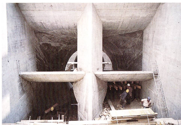
Bild 30. Im senkrechten Pfeiler des Einlaufbauwerkes ist die Lage- rung der Straflo-Turbine integriert.
