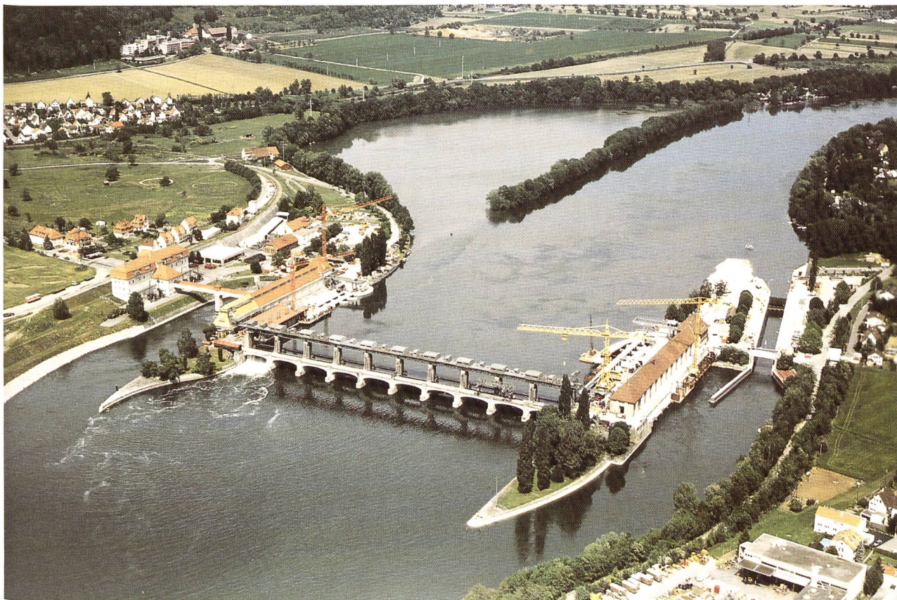
Bild 1. Die Kraftwerke Augst und Wyhlen während der Umbauphase. Im Gegensatz zu den meisten Flusskraftwerken sind die Maschinenhäuser rechtwinklig zum Wehr angeordnet.
