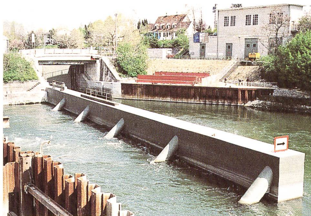
Bild 53. Die Leitmole dient gleichzeitig als Einfahrhilfe und als Strömungsumlenkung.
