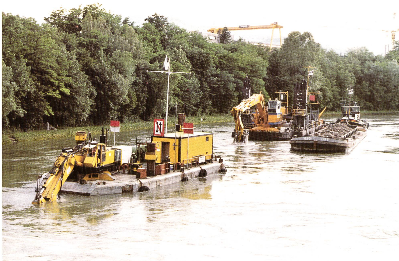
Bild 55. Für die Unterwasseraustiefung wurden Aushub- und Meisseleinheiten auf Stelzenpontons eingesetzt.
