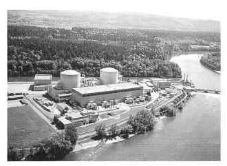
Seit 1966 werden die Temperaturen und chemische Zusammensetzung des Grundwassers an ausgewählten Stellen um das Kernkraftwerk Beznau gemessen und analysiert. Die Nutzung des Aarewassers zur Kühlung hat keine wesentliche Änderung der Grundwassertemperaturen bewirkt. (Foto: KKB/NOK)
