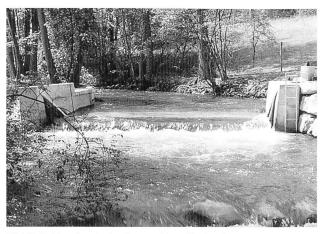
Bild 2. Schlauchwehr in abgesenktem Zustand.
