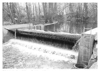
Bild 1. Luftgefülltes Schlauchwehr.
