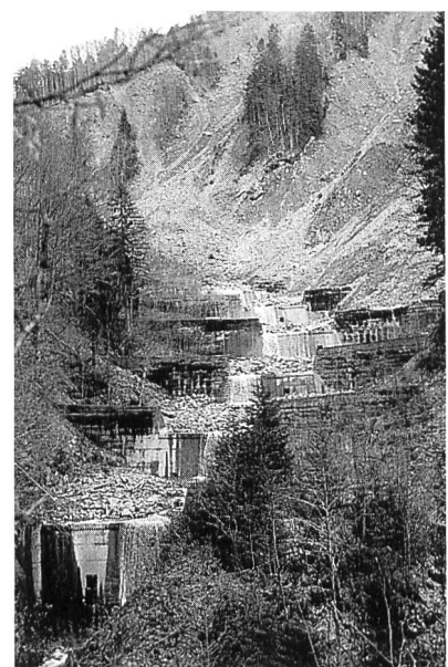
Bild 2. Die Sperren im Abstand von rund 40 m brechen die Wucht des Wassers, verhindern eine Vertiefung des Bachbettes und ein Nachrutschen der Berghänge.
