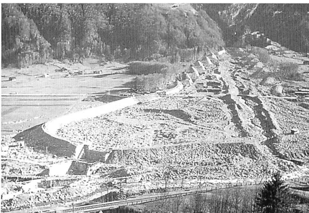
Bild 4. Ein Geschiebesammler, dessen Dämme 2000 m lang sind, umfasst jetzt das Mündungsgebiet des Wildbaches und bietet für die Umgebung einen Schutz (Foto datiert 13.11.1946).
