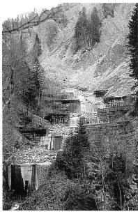
Bild 2. Die Sperren im Abstand von rund 40 m brechen die Wucht des Wassers, verhindern eine Vertiefung des Bachbettes und ein Nachrutschen der Berghänge.
