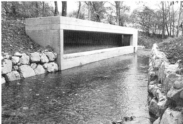
Bild 7. Das bereits fertiggestellte Zwischeneinlaufbauwerk Niederlenz mit Blick in Richtung Unterwasser wurde an der VAW rein numerisch untersucht (VAW 45/89–27).
