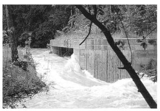
Bild 8. Das Einlaufbauwerk Niederlenz während eines Hochwassers am 19. Mai 1994: Vom Aabachzufluss (Q =  $20~\text{m}^3/\text{s}$ ) werden ca. 7 m $^3/\text{s}$  über das Streichwehr entlastet.
