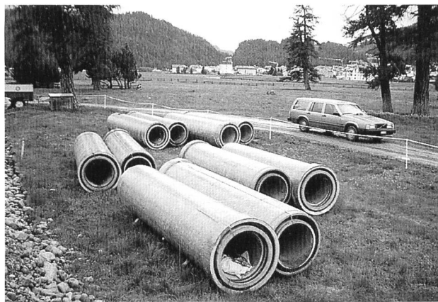
Bild 2. Doppelrohrleitungen «SECA» liegen auf der Baustelle zum Einbau bereit.
