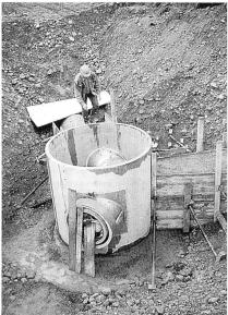
Bild 4. Winkelschacht mit Stahlrohreinbauten aus rostfreiem Material und entsprechenden Abstützungen bei Druckbetrieb.
