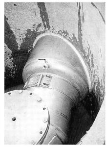
Bild 5. Winkelschachtdurchführung zwischen Aufnahme und Abschluss des Aussenrohrsystems samt Prüfanschluss für Druckproben.
