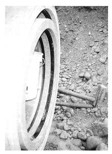
Bild 3. Detailaufnahme der Steckverbindung des «SECA»-Doppelrohrsystems.
