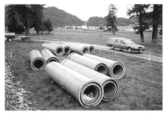
Bild 2. Doppelrohrleitungen «SECA» liegen auf der Baustelle zum Finbau bereit.
