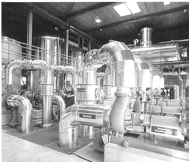
Bild 2. Pumpen mit Verteilleitungen und Netzwasserentgaser in der Hauptpumpenstation Beznau.
