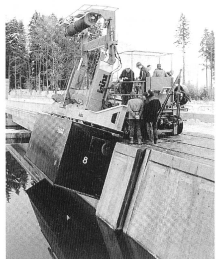
Bild 2, rechts, zeigt den Kran beim Einsetzen eines Dammbalkens.
