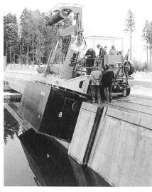
Bild 2, rechts, zeigt den Kran beim Einsetzen eines Dammbalkens.
