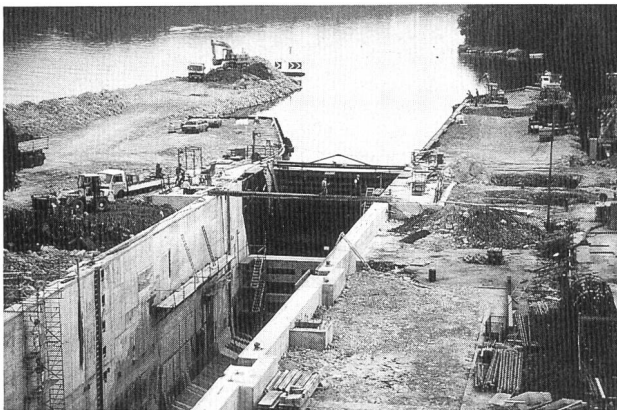
Bild 4. Die fast fertige Schleuse mit den oberen Einfahrhilfen. Das neue Drehsegmenttor ist eingebaut, und der Strömungsrichter aus Stahlbeton im leeren Schleusentrog ist sichtbar.
