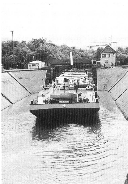
Bild 1, links. Talfahrt eines 85 m langen Lastschiffes aus der alten Schleuse mit den unter 45° geneigten Wänden. Vor dem Schleusvorgang mussten die Schiffe vom Land aus an die weit entfernten Poller am Trogrand angebunden werden.
