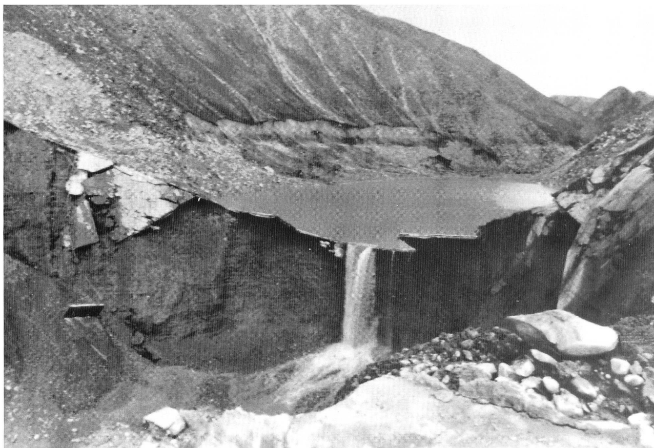
Bild 1. Der Gouhou-Damm in China nach dem Bruch. Blick von der Luftseite auf die Bresche. Teile der wasserseitigen Betondichtung hängen über den ausgewaschenen, kiesigen Stützkörper und bieten dem auslaufenden Wasser noch einen gewissen Widerstand. Die rasche Leerung des Stausees verursachte einige Hangrutsche an den Talflanken (Bild: New China News Agency).
