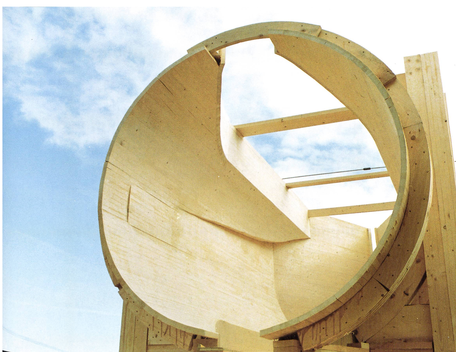
Vorfabrizierte Schalung für den Turbinen-Einlaufbereich beim Kraftwerk Augst. Die gleiche Schalung wurde für alle sieben neuen Einheiten verwendet.
