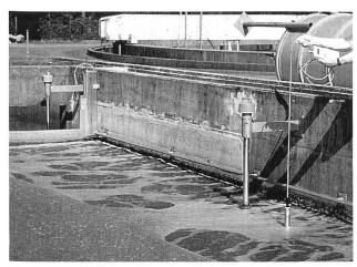
Bild 1. Messung des Feststoffgehaltes im Belebungsbecken mit Cosmos.
