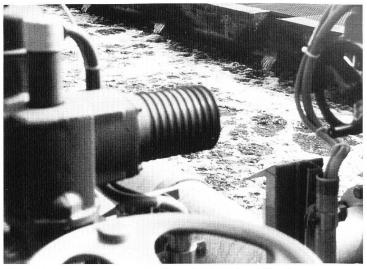
Bild 2. Motorschieber für das Belüftungsbecken einer Kläranlage.
