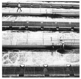
Bild 1. Belüftungsbecken einer Kläranlage mit Tiefenbelüftung.
