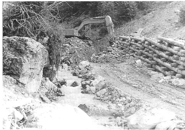
Bild 2. Die massiven Holzkastenwuhren werden mit Bruchsteinen und erdigem Aushubmaterial aufgefüllt und überdeckt. Die schweren Vorbausteine schützen nicht nur die Holzkastenwuhren vor Beschädigungen durch Hochwasser, sie bieten auch Forellen und Kleintieren gute Unterschlupfmöglichkeiten. Diese aus natürlichen Materialien erstellten Verbauungen sorgen künftig für eine Stabilisierung des Rutschhangs im Uferbereich und für einen ungehinderten Durchfluss des Schmuerbach-Wassers.
