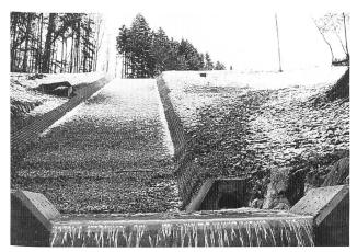
Bild 2. Hochwasserentlastungsrinne nach Fertigstellung im Spätherbst 1991.
