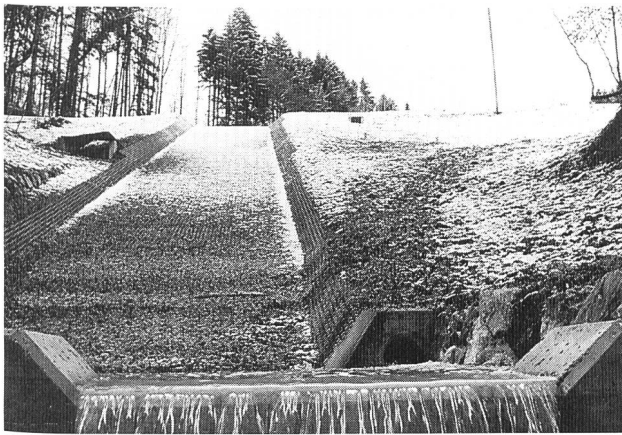
Bild 2. Hochwasserentlastungsrinne nach Fertigstellung im Spätherbst 1991.
