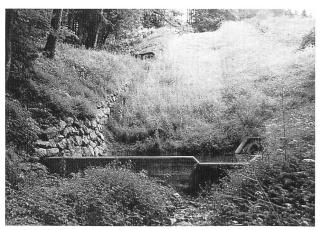
Bild 3. Fast vollständig bewachsene Hochwasserentlastungsrinne im Frühsommer 1993.
