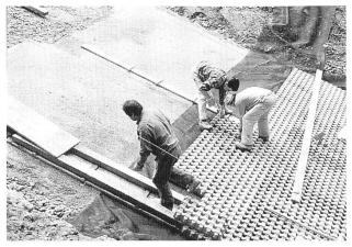
Bild 1. Verlegung der UK-Wasserbauelemente in der Schussrinne.
