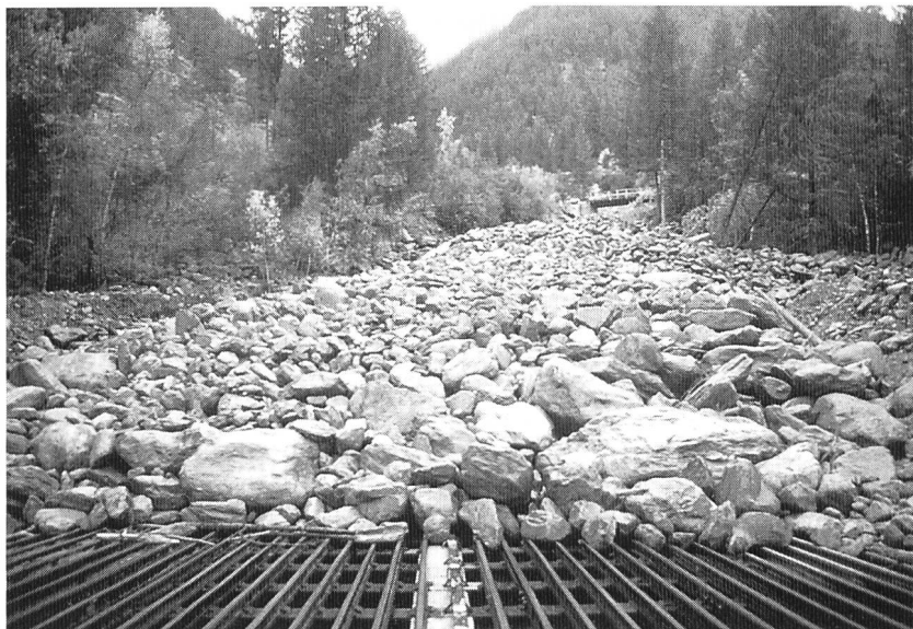
Bild 6, links: Murgangsbremse (horizontaler Rost): Länge 19 m, Breite 12 m. Bachabwärts ist der Rückhaltedamm zu erkennen (Pfeil). Photo vom 30. April 1993
