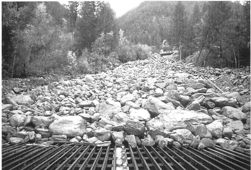
Bild 6, links: Murgangsbremse (horizontaler Rost): Länge 19 m, Breite 12 m. Bachabwärts ist der Rückhaltedamm zu erkennen (Pfeil). Photo vom 30. April 1993
