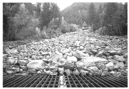
Bild 6, links: Murgangbremse (horizontaler Rost): Länge 19 m, Breite 12 m. Bachabwärts ist der Rückhaltedamm zu erkennen (Pfeil). Photo vom 30. April 1993
