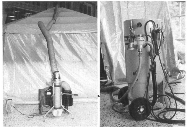
Figure 2, à gauche. Evacuation de l'air vicié.
