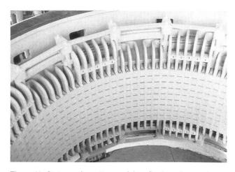
Figure 11. Stator après nettoyage à la rafle de maïs et peinture isolante.
