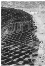
Bild 4. links. Geozellen von Bild 3 mit Kies gefüllt.
