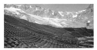
Bild 3. Sicherung der Dammböschung des Speichersees mit Geozellen aus Kunststoff.
