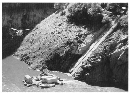
Bild 6. Pontoneinrichtungen für die Unterwasserarbeiten und das Absenken des Einlauftrichters.
