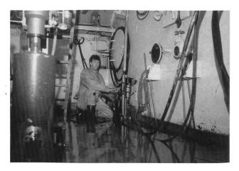
Bild 8. Bohr- und Ausbrucharbeiten in der Druckkabine bei etwa 20 m Wasserdruck.
