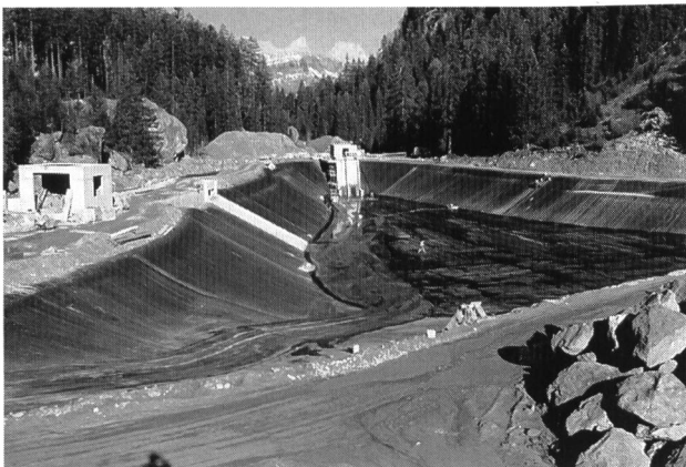
Bild 1. Ausgleichsbecken Merlen nach dem Einbau der Asphalt-dichtung.
