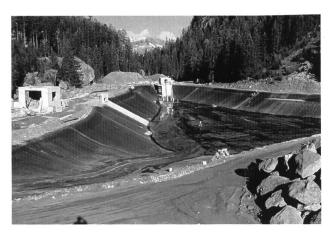
Bild 1. Ausgleichsbecken Merlen nach dem Einbau der Asphaltdichtung.
